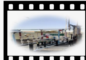
VAPL P/L Project
