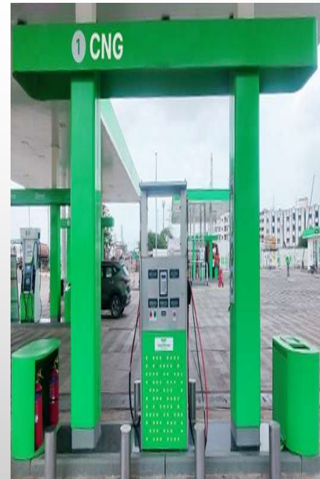
CNG RO & CGD
