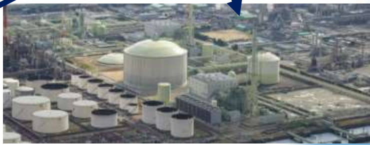
Senboku LNG Terminal 1 (online 1972) 1 LNG tank , annal vaporization capacity 1.9 million tons
