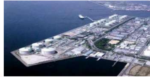
Senboku LNG Terminal 2 (online 1977) 16 LNG tanks Annual vaporization capacity 10 million tons
