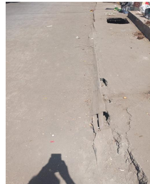
Edge to edge concrete
